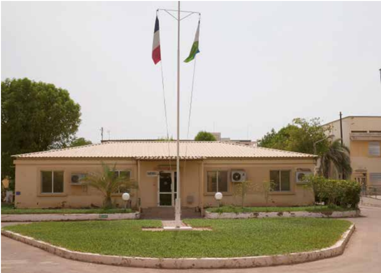
Fig. 3 : Bâtiment de la chefferie de l'HMC Bouffard en aout 2015
